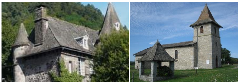
Maison du chevalier des Huttes (Vic-sur-Cère), Chapelle du Bourniou à Roumegoux
