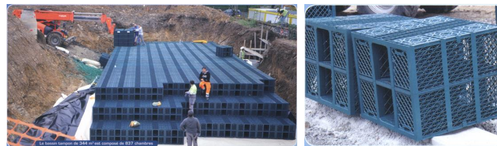
- Bassin de rétention des eaux pluviales de 344 m 3 construit au stade Jean Alric à Aurillac - (source : AGGLOmag n° 57)
